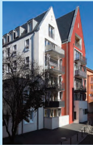
Wohnen am Dom, Frankfurt am Main Christoph Mäckler Architekten Foto © Thomas Eicken
