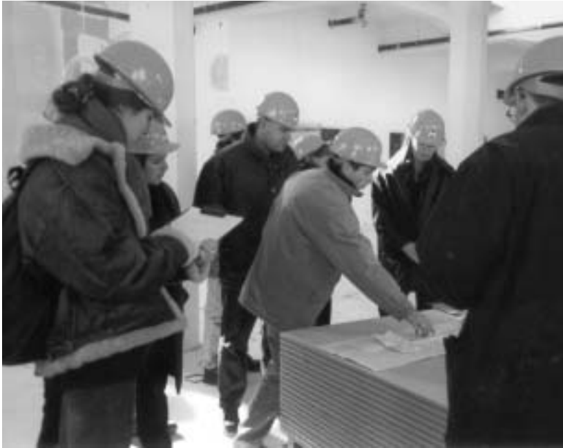
Hier werden sie später mal arbeiten: MitarbeiterInnen einer Werbeagentur während der Führung durch die Baustelle ihres neuen Büros.
